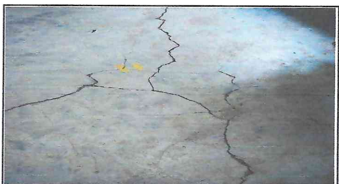
Foto 4: cambio de torta de cemento a piso ceramico dentro de las aulas
