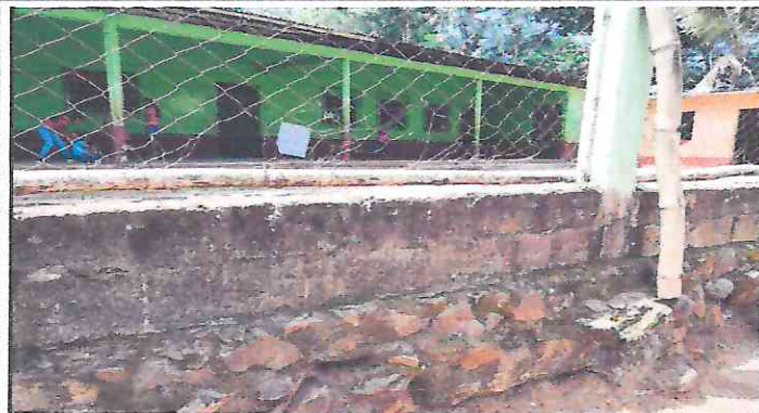
Foto 1: sustituir muro perimetral de malla a muro de block
