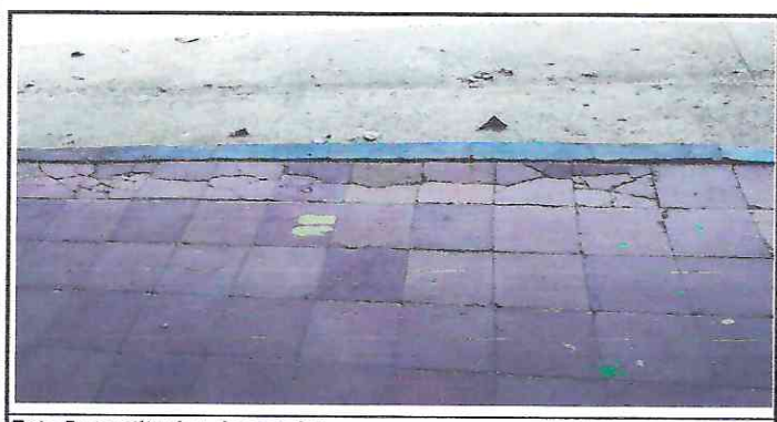
Foto 5: sustitucion de corredor
