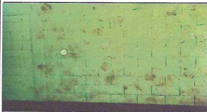
Foto 3: cambio de pintura externa y interna del establecimiento
